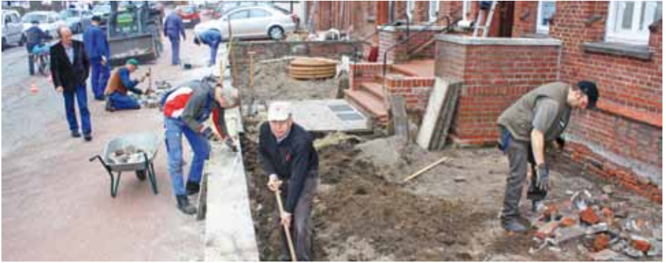
Bei den Stationen 1 und 2 vor dem ersten Pfarrhaus musste der Boden erst vorbereitet werden
