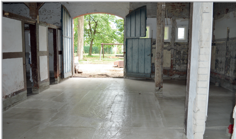
Foto oben: Blick in den neu angebauten Gemeindesaalabschnitt Foto unten: Türöffnungen zum Jugendraum (links), Küchenbereich (rechts) und mittig ist viel Platz für Begegnungen, am ersten Pfeiler erkennt man schon den Anfang der Rampe, die in den Gemeindesaal führen wird Fotos: Tina Cohrsen
