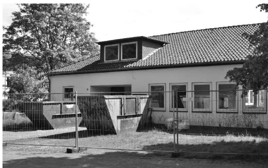
Umbauarbeiten am Gemeindehaus haben begonnen, Stand Mai 2014
