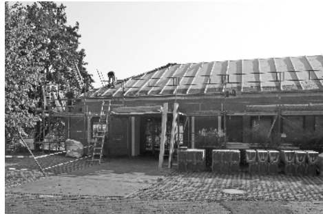
Die Klosterkammer Hannover hat das Dach des Gemeindehauses neu eindecken lassen
