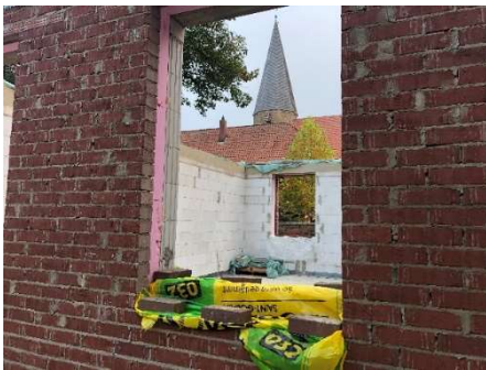
Bau eines neuen Pfarrbüros
