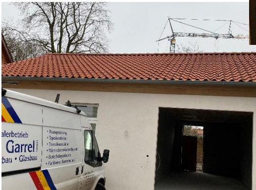
Die Bauarbeiten am Anbau zum Pfarrhaus schreiten voran!
